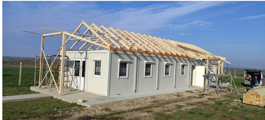
Az asszonyvárosi roma imaház építése
